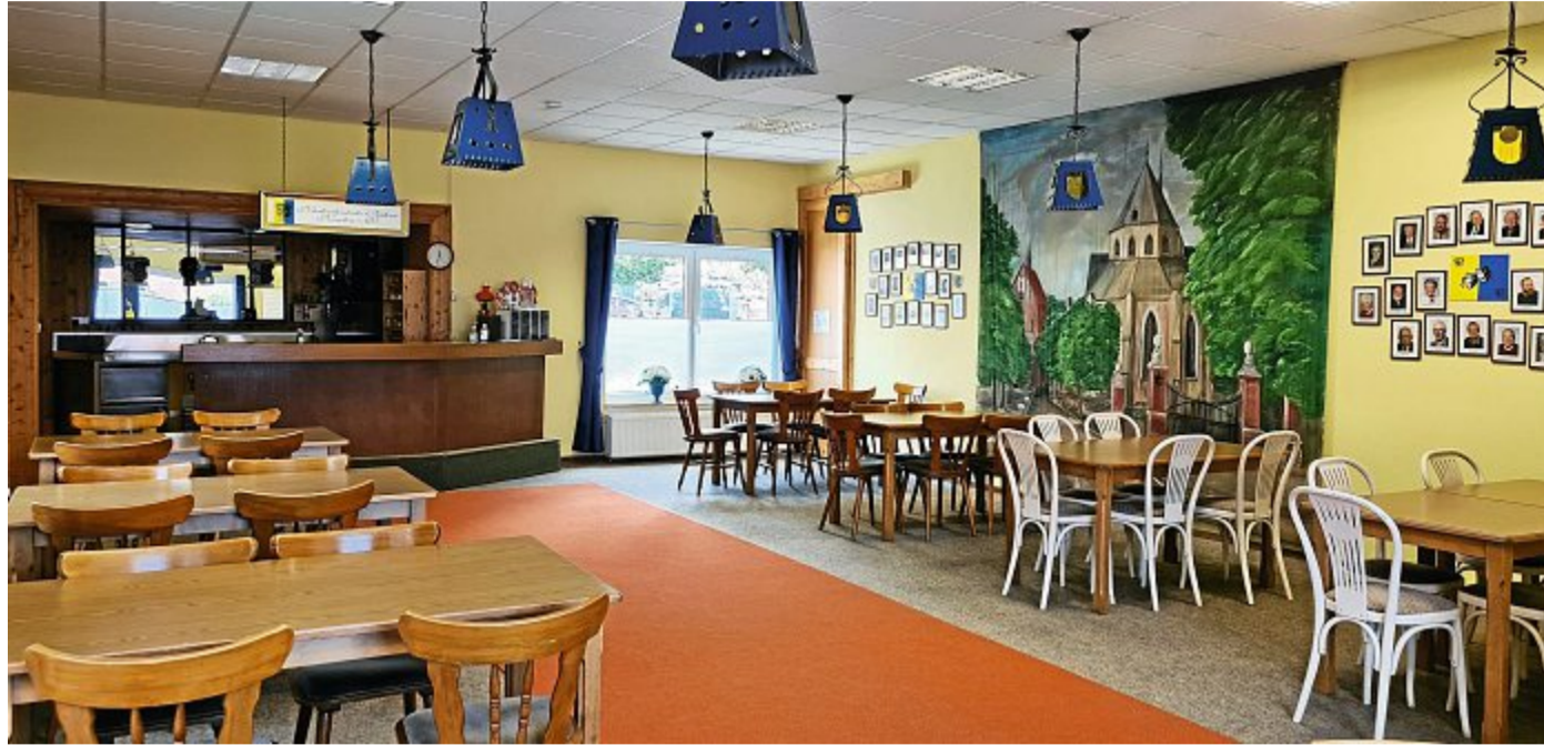
Der Versammlungssaal der Norder Bühne: Die Bühnenbauer haben die Risse in den Wänden, die durch den Wasserschaden entstanden waren, beseitigt und den Raum wieder gestrichen und renoviert. Der Fußboden muss noch erneuert werden. Foto: Magret Martens
